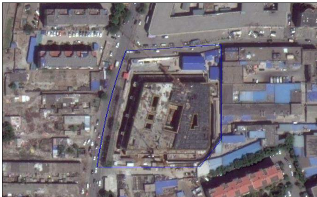
图 3-2 项目施工期遥感影像(2016.05)
